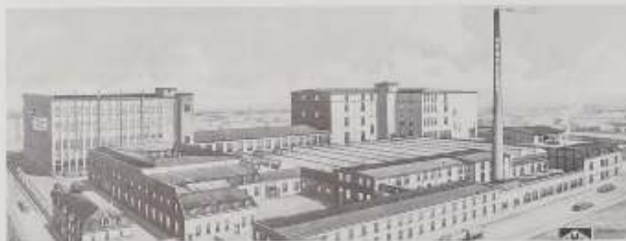
Die Hercules-Werke Ende der 50er Jahre, nach dem Umbau
